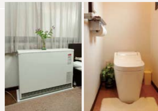
右・中／2つあったトイレを一つにリフォーム。廊下の空間が広がり、窓から明かりが差し込みます。左／蓄熱暖房機。下の風向口から静かに温風が部屋をじんわりじっくり温め、自然と暖かくなります。
